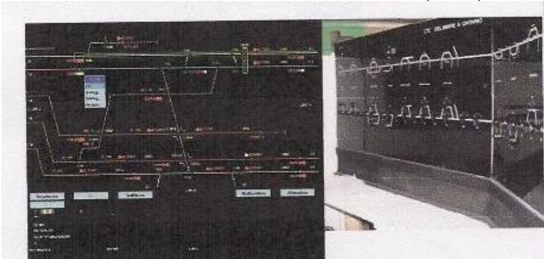
FIGURA 4 – PÁINEL MIMICO CINÉTICO - CCO
